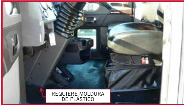
Figura 9 - Montaje de la columna de dirección
