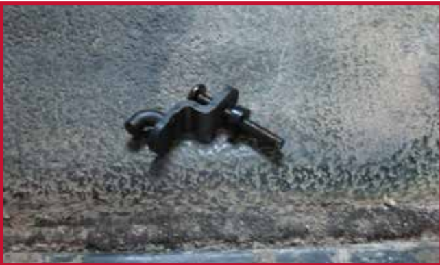
Figure 7 – Assemblage de crochet et d'espaceur
